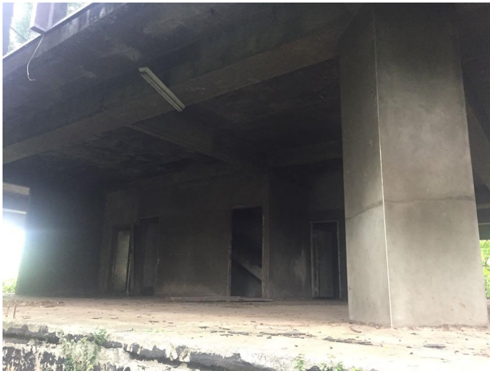
Figura 21 - Atual situação do edifício
