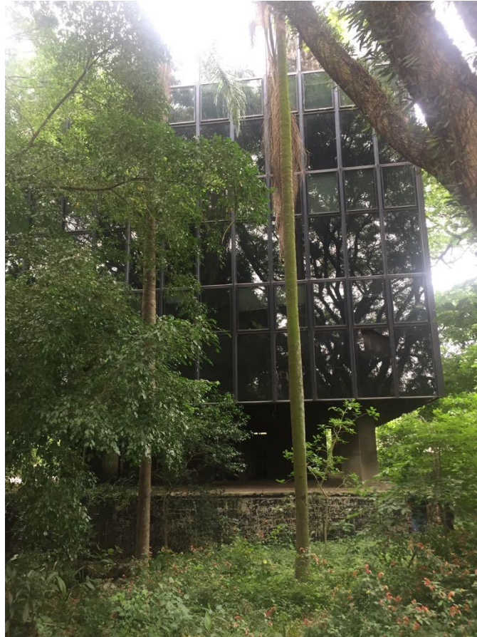
Figura 20 - Atual situação do edifício
