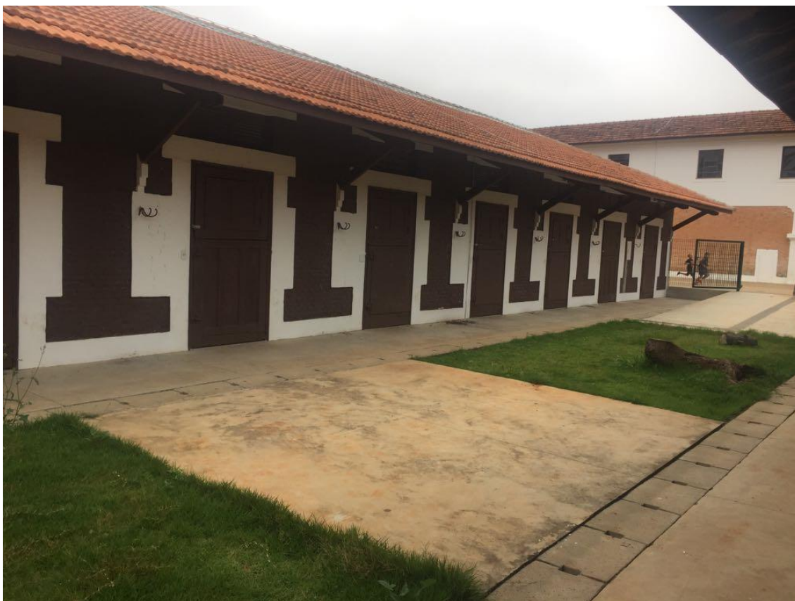
Figura 19- Baias já reformadas
